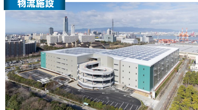
プロロジスパーク大阪5 大阪市住之江区南港東 日本プロロジスリート投資法人
